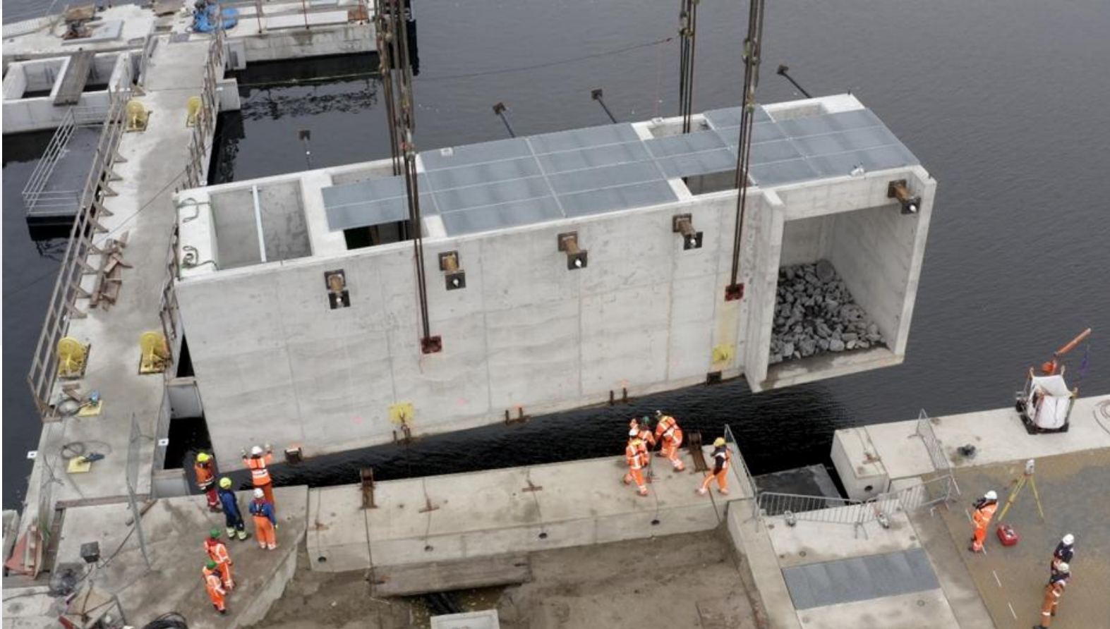
Aanzicht vispassage t.p.v. landhoofden
